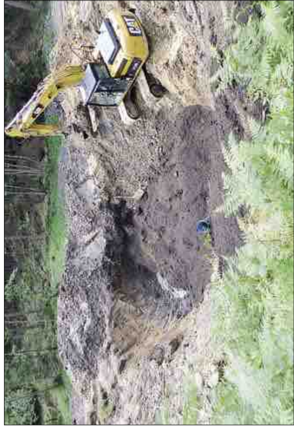
Abbildung 22: Kampfmittelräumung eines Trichters. Oben links: Aushub eines Doppeltrichters; Oben rechts: Einbau eines Beweissicherungsrohres für Monitoringmaßnahmen; Unten links: Einfüllung von Kompost; unten rechts: lagiger Einbau von Kompost.
