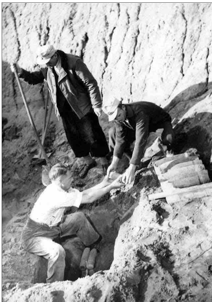
Abbildung 7: Vernichtung von Munition auf der E-Stelle in Feucht. Ein Stapelmeister (nicht im Bild) gibt vor, wie die Munition anzuordnen ist, damit sie komplett detoniert. In diesem Fall wird eine Bombe verwendet, um die die zu sprengenden Granaten angeordnet werden.
