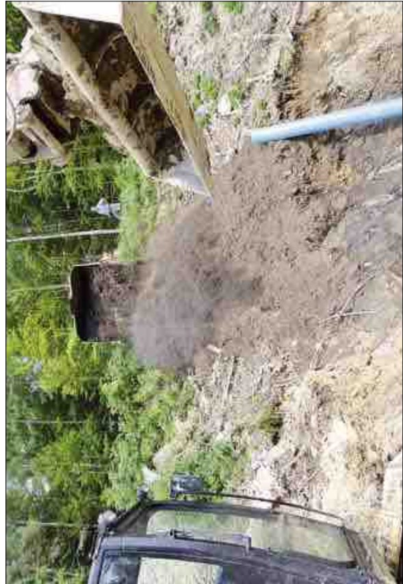
Abbildung 22: Kampfmittelräumung eines Trichters. Oben links: Aushub eines Doppeltrichters; Oben rechts: Einbau eines Beweissicherungsrohres für Monitoringmaßnahmen; Unten links: Einfüllung von Kompost; unten rechts: lagiger Einbau von Kompost.
