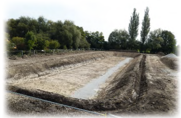
Ein Erdbecken zur Reinigung kontaminierter Erde wird errichtet
