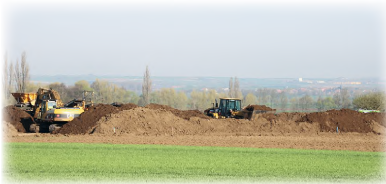
Fläche wird abgeräumt und Humusmieten angelegt.
