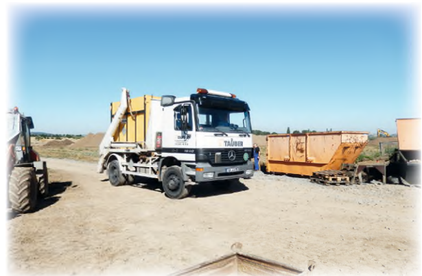
Abtransport von Munition durch Sprengkommando
