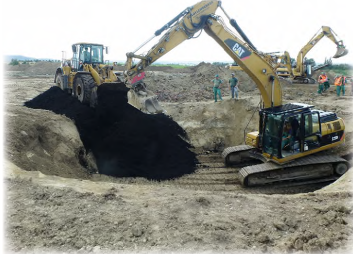
Sanierungskonzept (oben) und die Umsetzung im Feld (unten).
