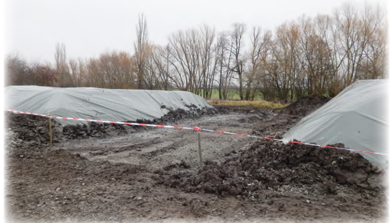
Kontaminiertes Erdreich in Mieten abgedeckt
