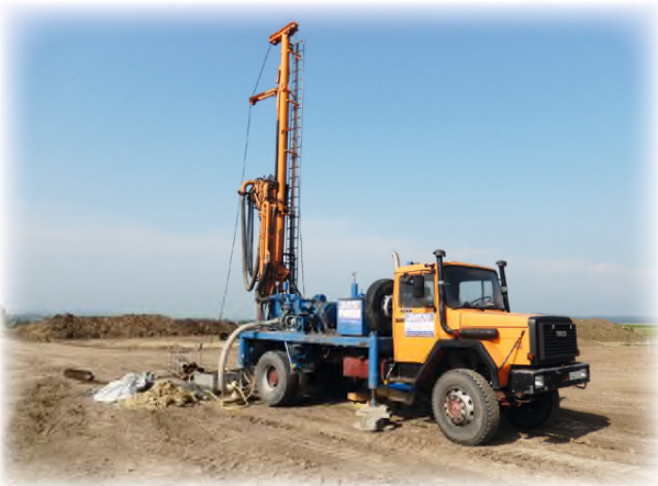
Bohranlage für Grundwassermessstellen
