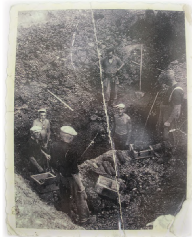
Räumung in den 50er-Jahren. Umgraben eines Sprengtrichters.
