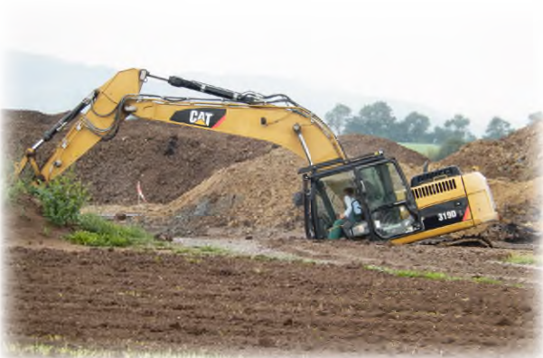
Baggerarbeit im Trichter
