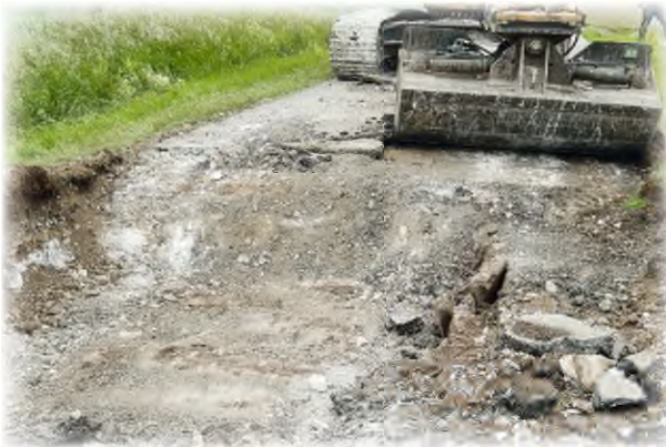
Sondierung der Wege
