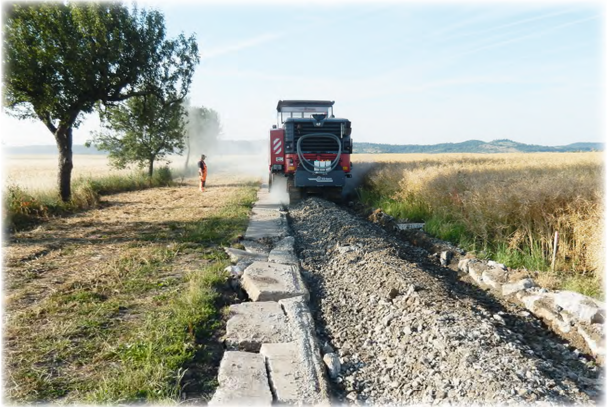
Bearbeitung des Betonplattenweges nach erfolgter Kampfmittelräumung
