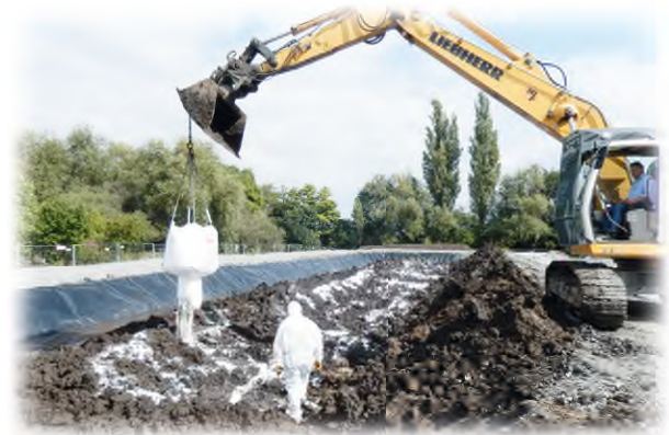
Kontaminiertes Erdreich wird eingefüllt und behandelt
